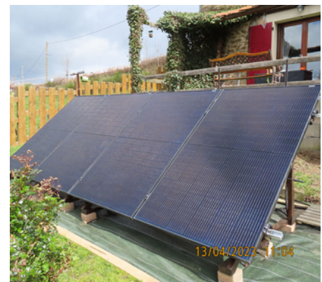
Exemple d'installation d'un kit au sol de 4 panneaux sur support autoconstruit
