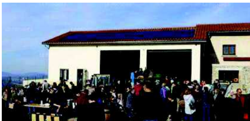
Des panneaux photovoltaïques ont été installés sur le toit du local technique. Photo Jean-Claude VOUTE
