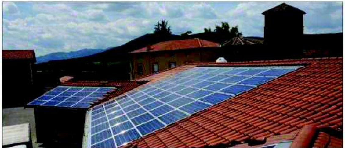
■ 15 sites d'environ 60 m 2 , six sites d'environ 250 m 2 , deux sites de 600 m 2 et un site d'environ 1 000 m 2 ont été visités. Photo C.V. TALEV
