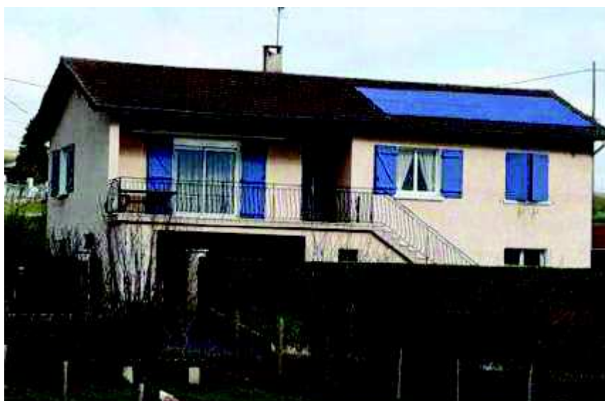
Monts Énergies loue des toitures pour installer des panneaux photovoltaïques. Photo Jean-Claude VOUTE
